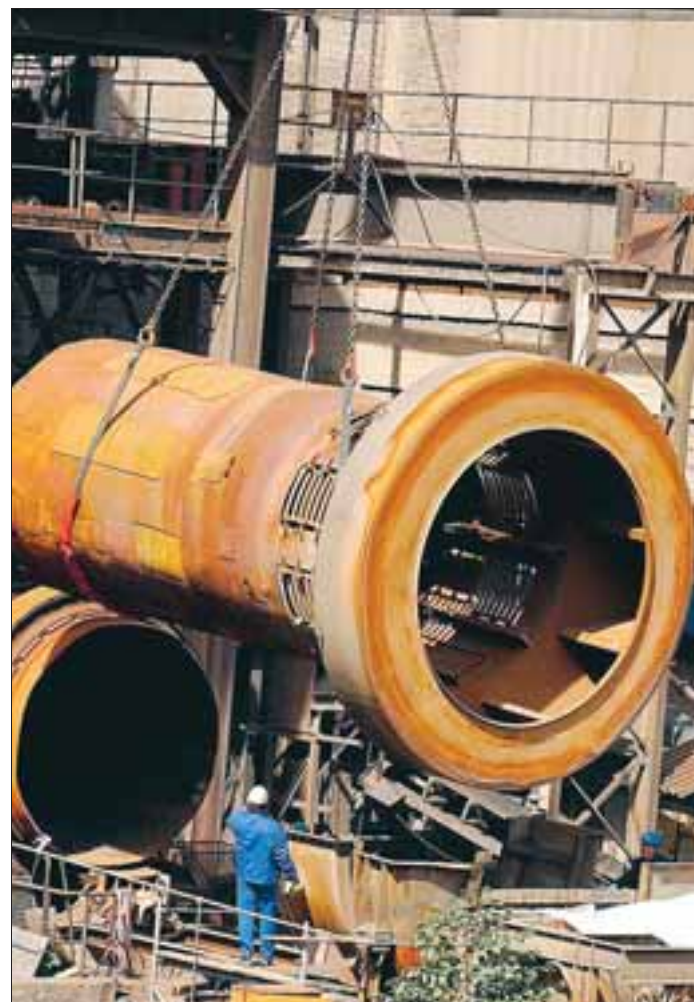
Bei einer turnusgemäßen Komplexreparatur in der VTS Koop Schiefer GmbH in Unterloquitz (Landkreis Saalfeld-Rudolstadt) wird ein 20 Tonnen schweres Kühlerteil am Drehrohrofen gewechselt. In dem Ofen wird Schiefergestein auf 1200 Grad Celsius erhitzt, um sein Volumen zu vergrößern. (Foto: OTZ/Klaus Moritz)
