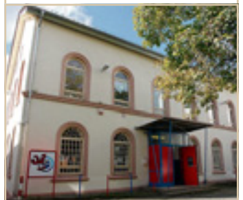
Das Außengelände des Burbacher Jugendzentrums wurde jetzt wieder auf Vordermann gebracht
